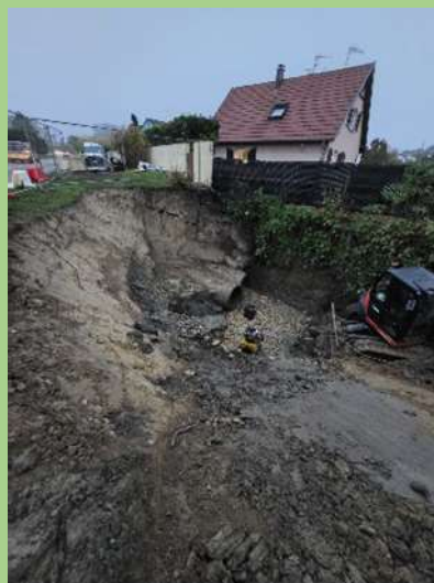
Enrochement du fossé à l'entrée du village
